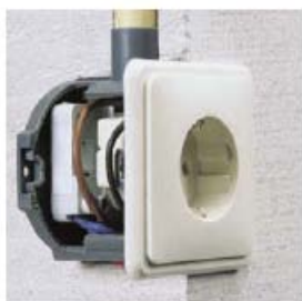
ماژول توکار پشت کنید ، پریزهای موجود قرار می گیرد
